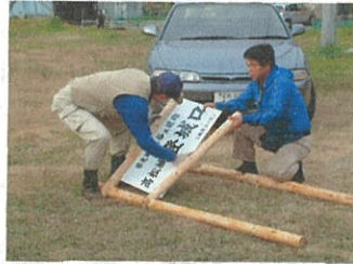
登城口案内板の組立て
